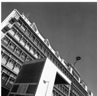
ciment armé soutenue par des pieux en béton. Ceux-ci sont enfoncés de 15 mètres car le sol est très instable, il
